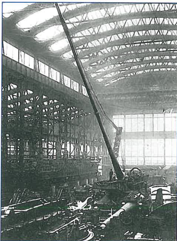
Bild 3. Pariskanonen under tillverkning hos Krupp i Essen.
